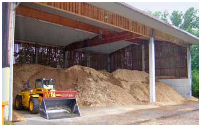
Vorbildliche Lagerhalle (Foto: LWF)
